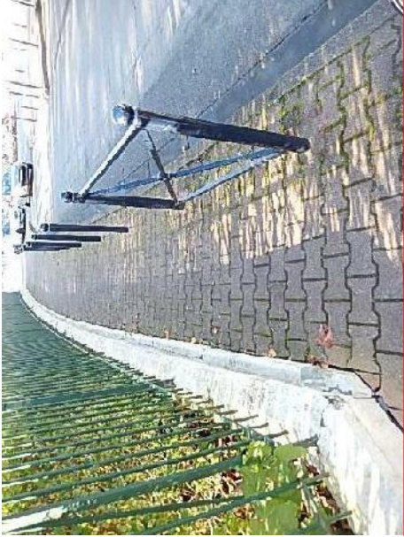
20 / Trotoir de 150 cm avec obstacles Réduisant le passage à 120 Ave. De Verdun
