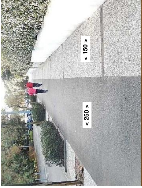
17 / Pas de séparation tactile entre PC et cheminement Pas de logos vélos Boulevard de l'Océan
