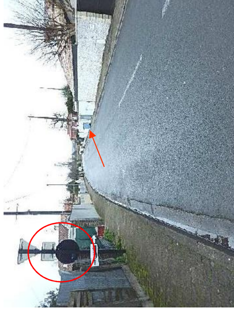
76 / Panneau trop bas et trottoir de 1 m à gauche Rue des Chasseurs
