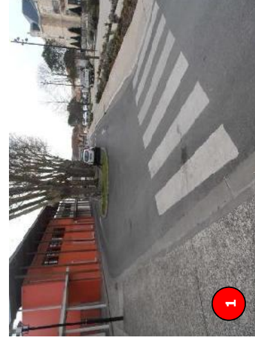
Absence de BEV côté gauche et absence de contraste de la BEV côté droit (T6)
