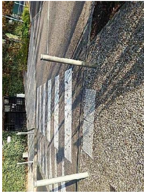
1 / Potelets et BEV sans contraste Bande d'éveil pas assez large Blvd de l'Océan / av. du Bassin
