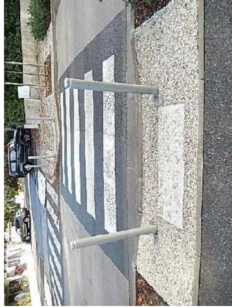
22 / BEV pas assez large et sans contraste Potelets sans contraste Boulevard de l'Océan
