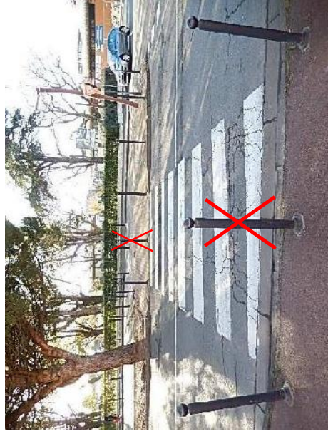
11 / Obstacle sur la traversée Absence de BEV Potelets sans contraste Av. de Verdun
