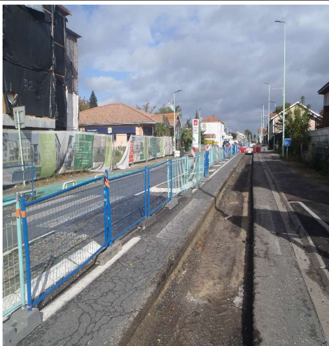
Vue de la tranchée et du collecteur mis en place
