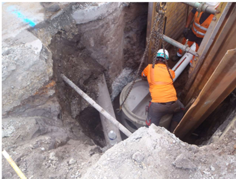
Vue de la tranchée Pose d'un regard de visite
