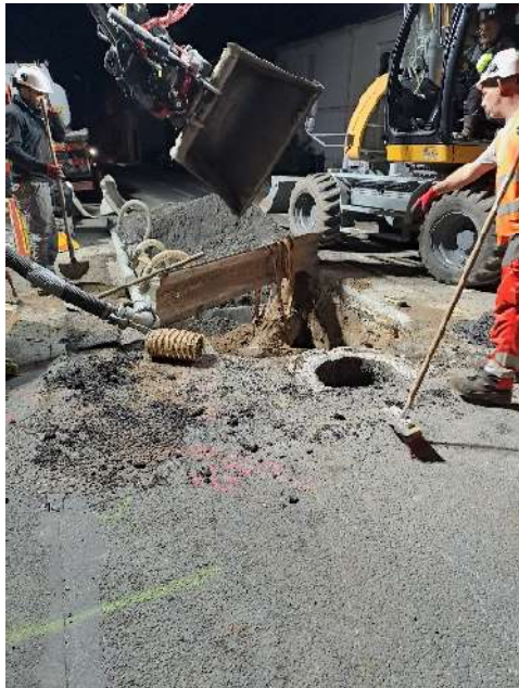
Travaux de nuit – Tranchée
