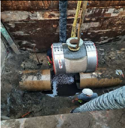
Mise en place Té sur collecteur Ø1000
