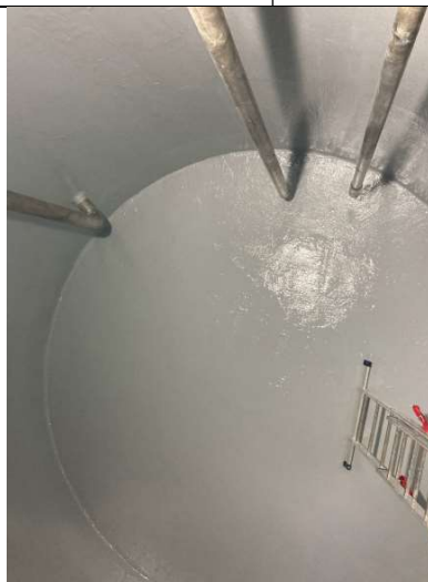
Mise en place revêtement sur cuve à hydrolyse- STEP BIGANOS
