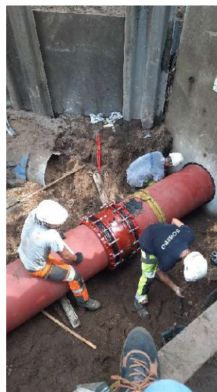
Réalisation assemblage Té-allonge-vanne et ventouse
