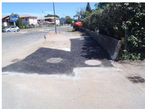
Vue des ouvrages de visite après réfections de voirie
