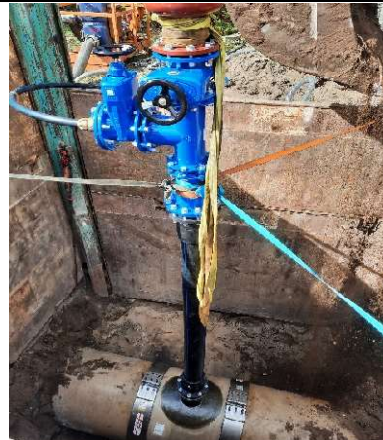
Réalisation assemblage Té-allonge-vanne et ventouse
