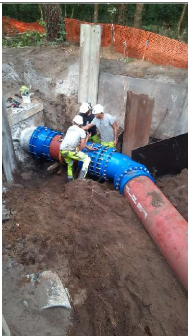
Mise en place Té sur collecteur Ø1000
